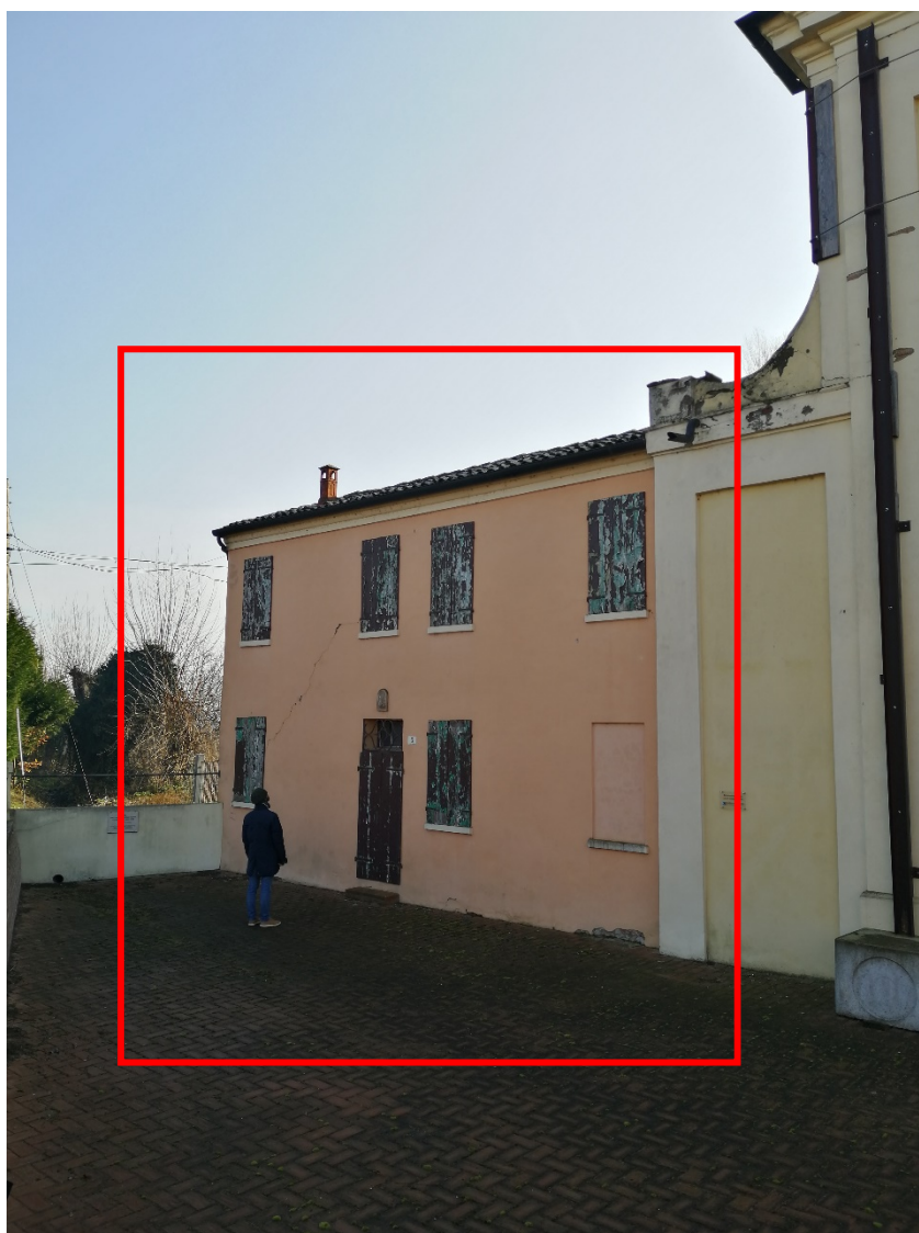
Edificio oggetto di demolizione
