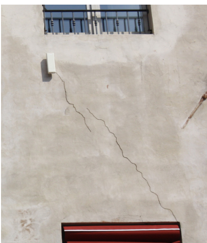
Lesioni in corrispondenza dell'intonaco visibili nella grande corte centrale
