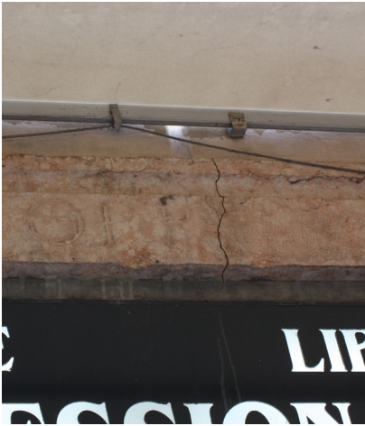
Lesioni in corrispondenza degli elementi lapidei dei prospetti esterni principali
