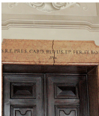
Lesioni visibili in corrispondenza degli elementi lapidei
