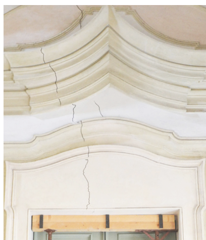
Lesioni visibili in corrispondenza degli elementi lapidei
