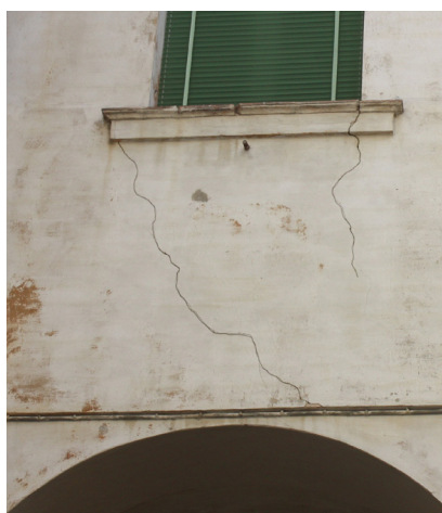
Lesioni in corrispondenza dell'intonaco visibili nelle corti laterali
