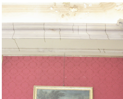
Lesioni visibili sulle modanature in stucco
