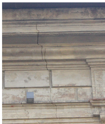
Lesioni sull'intonaco liscio e a bugnato e sulle cornici modanate visibili sui prospetti principali
