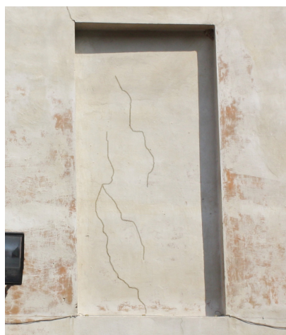
Lesioni in corrispondenza dell'intonaco visibili nella grande corte centrale
