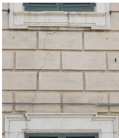
Lesioni sull'intonaco liscio e a bugnato e sulle cornici modanate visibili sui prospetti principali
