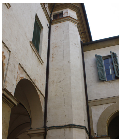
Lesioni in corrispondenza dell'intonaco visibili nelle corti laterali
