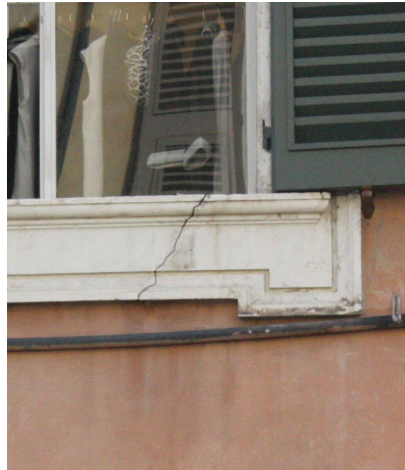
Lesioni in corrispondenza degli elementi lapidei dei prospetti esterni principali
