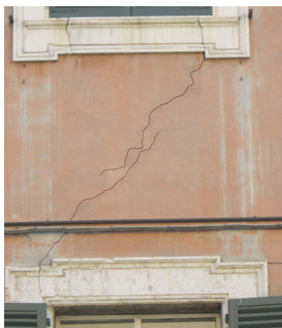
Lesioni sull'intonaco liscio e a bugnato e sulle cornici modanate visibili sui prospetti principali
