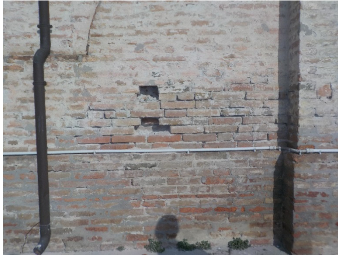
Figura 5: rimozione degli intonaci per il rilievo delle tessiture murarie
