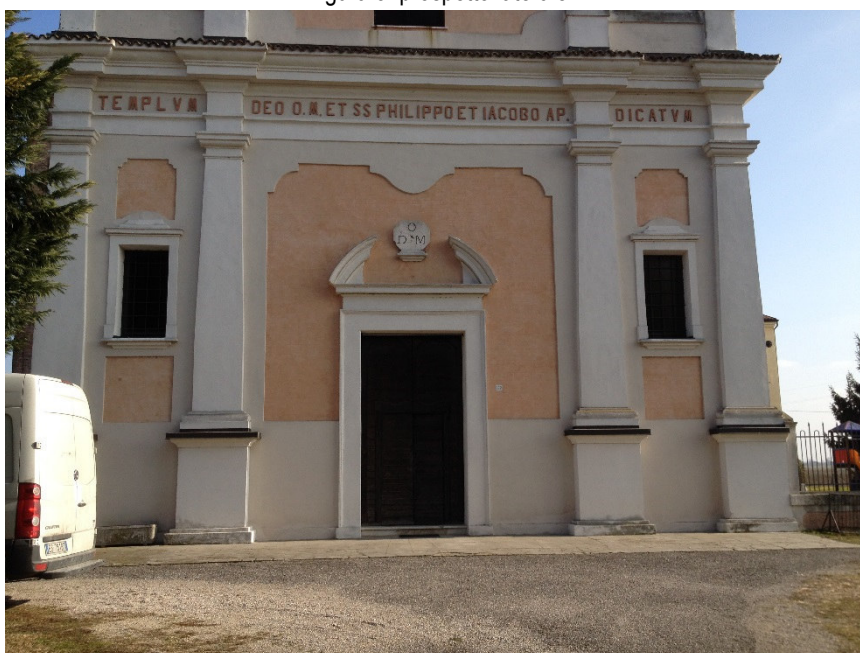
Figura 4: porzione della facciata di ingresso
