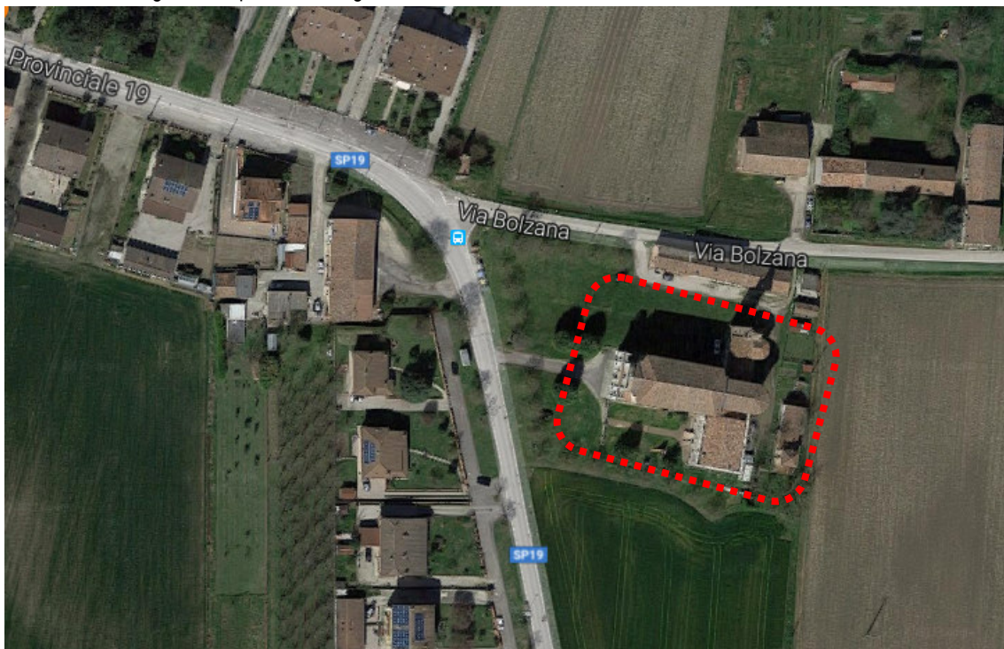
Figura 2: vista aerea con identificazione dell'edificio oggetto di indagine
