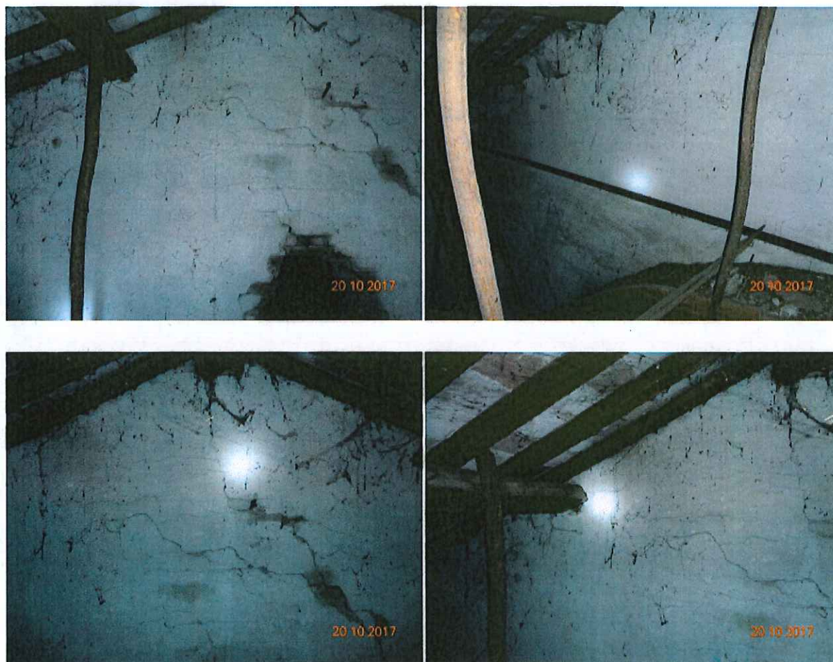
Figura 6 – lesioni dell'arco trionfale
