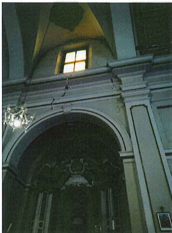
Foto 10 – lesioni verticali per le cappelle laterali
