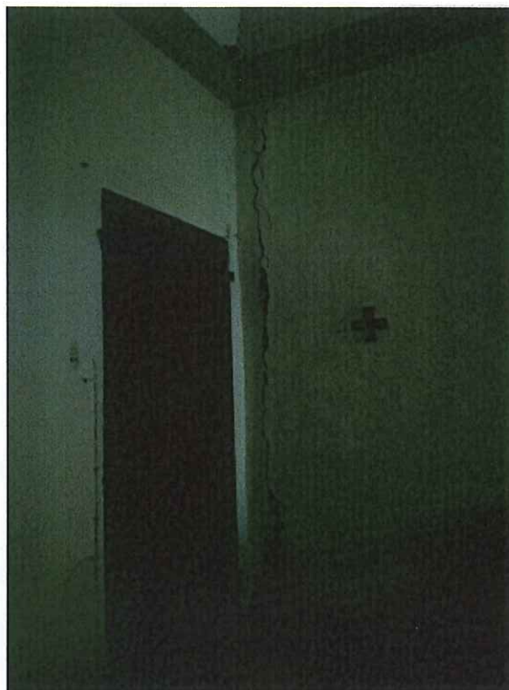
Foto 5 - Distacco tra la cappella d'inverno ed il corpo della Chiesa
