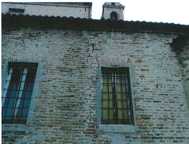
Foto 4 - Lesioni e sconnessioni degli architravi della cappella d'inverno
