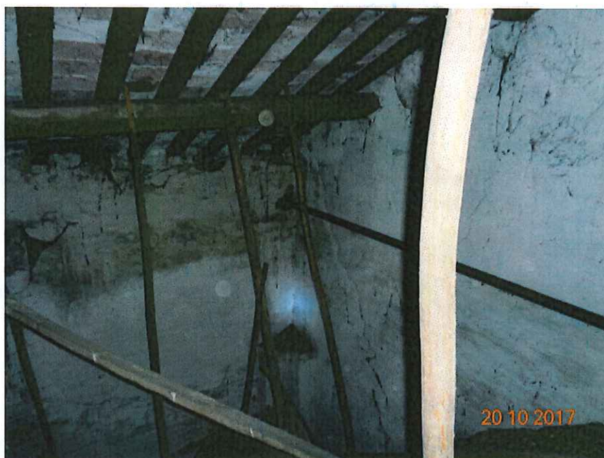
Foto 3 – presenza di una catena metallica ossidata, visibili le lesioni dell'arco trionfale.
